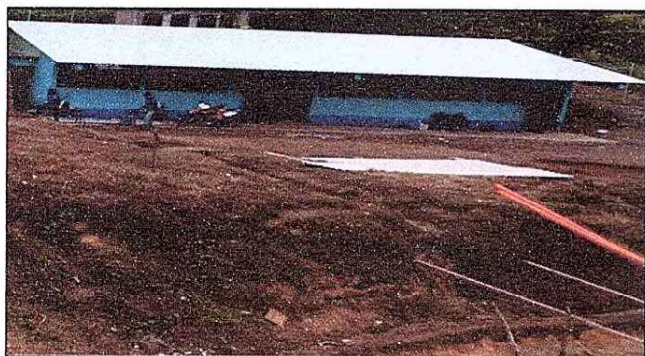
Foto 3: Evidencia de la colocacion de láminas del módulo.
