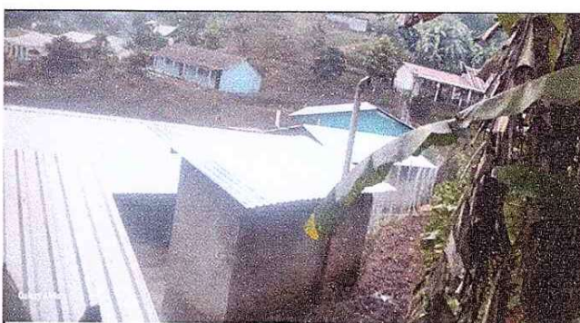
Foto 4: Se evidencia la colocación de láminas de una de los dos baños existentes.
