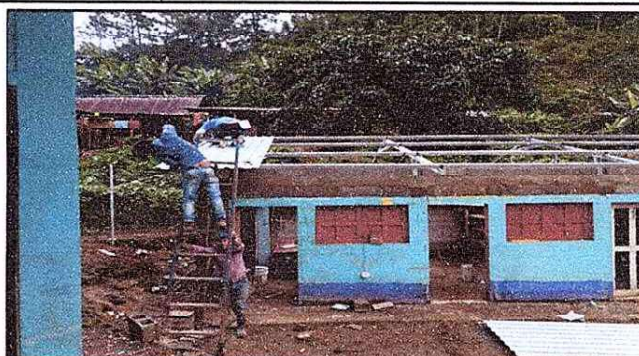
Foto 2: Se observa la renovación de este módulo colocación de láminas y cambio de costaneras.
