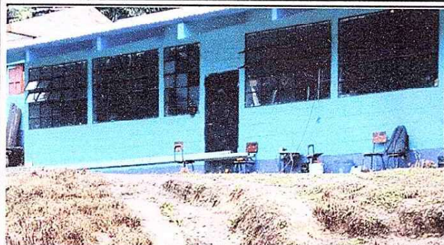
Foto 1: Se evidencia el mejoramiento del aula, cambio del entechado.
